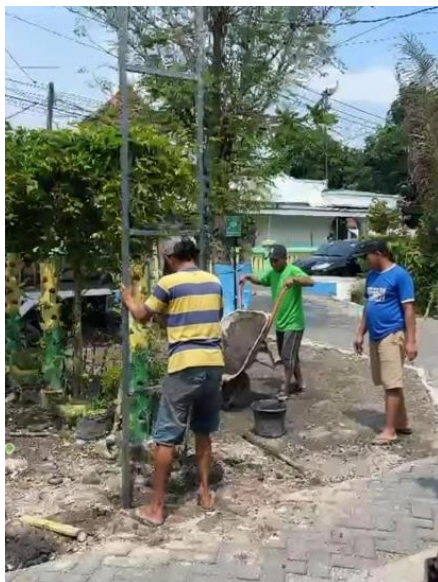
Gambar 1. Pemasangan kerangka dan edukasi ecoprint
