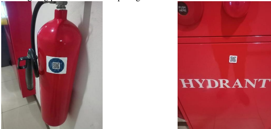
Gambar 1. Pemasangan qr code pada alat apar dan hydrant
